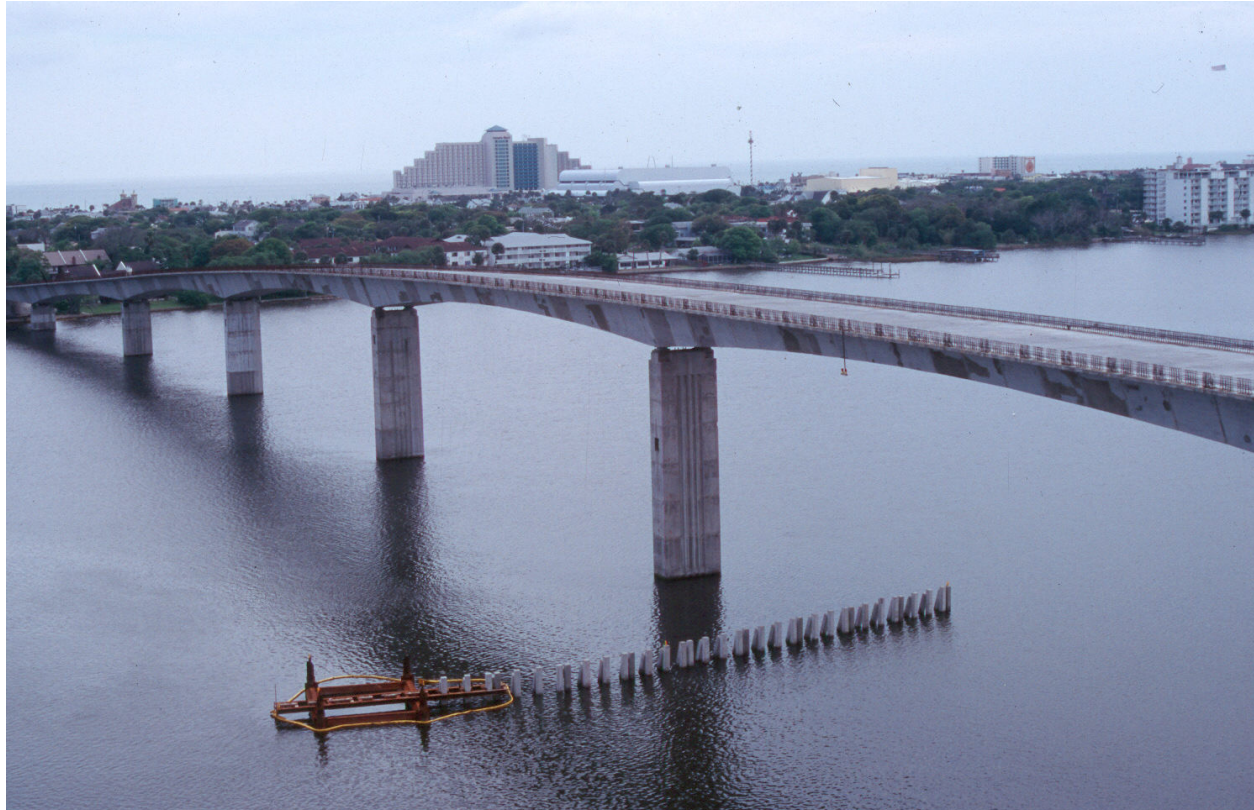
Causeway en Floride – Cendres volantes utilisées pour augmenter la résistance à la pénétration des ions chlore.
